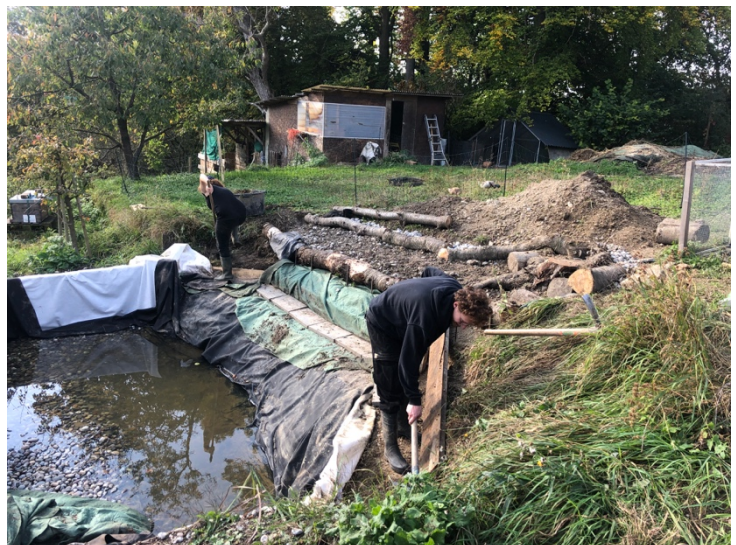
Atelierschüler beim Bau der Böschung
